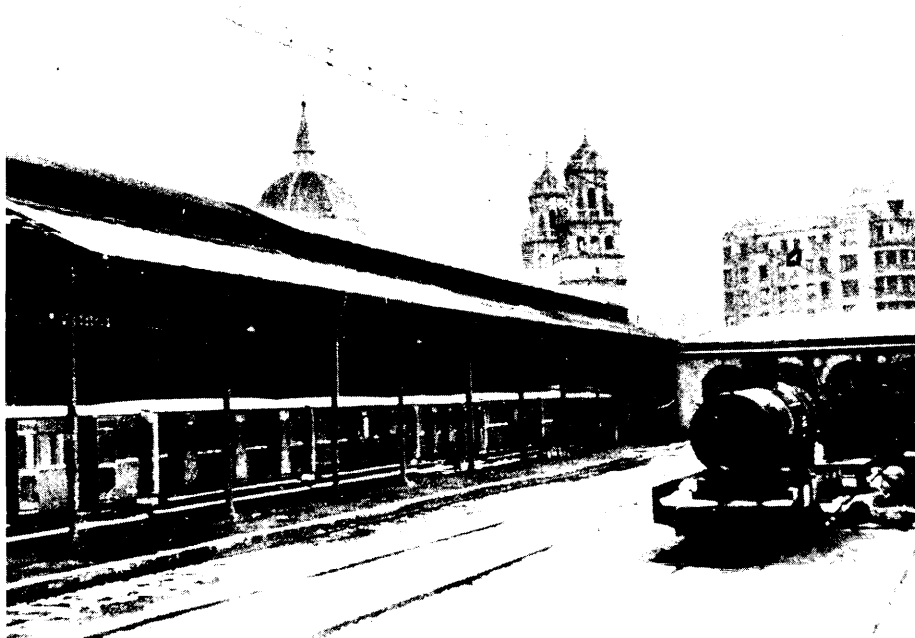
Ferrocarril de Langreo: Edificio del andén de viajeros. Años 50.
