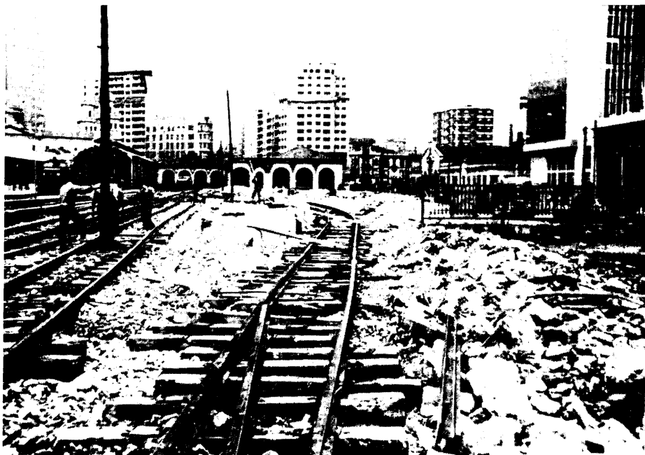
Ferrocarril de Carreño: Construcción de la estación en terreno del Ferrocarril de Langreo. Año 1968.
